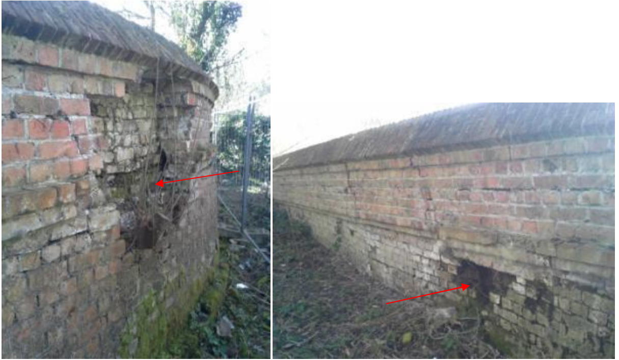
Aan de achterzijde wordt door het wegnemen van enkele bakstenen een toegang voorzien voor Eikemuizen naar de zijdelen van de oude paardenstallen
