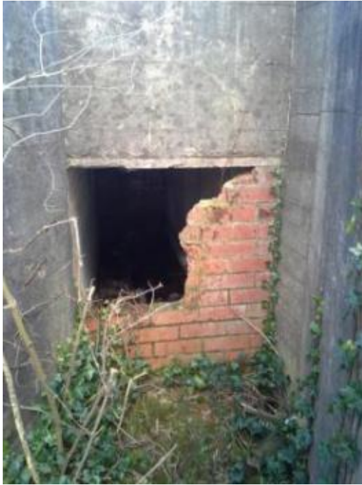
ingang waar ijzeren deur wordt geplaatst
